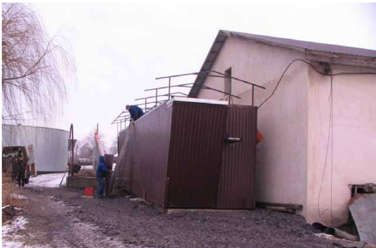
Fot. 8. Montaż zadaszenia nad KMR7
