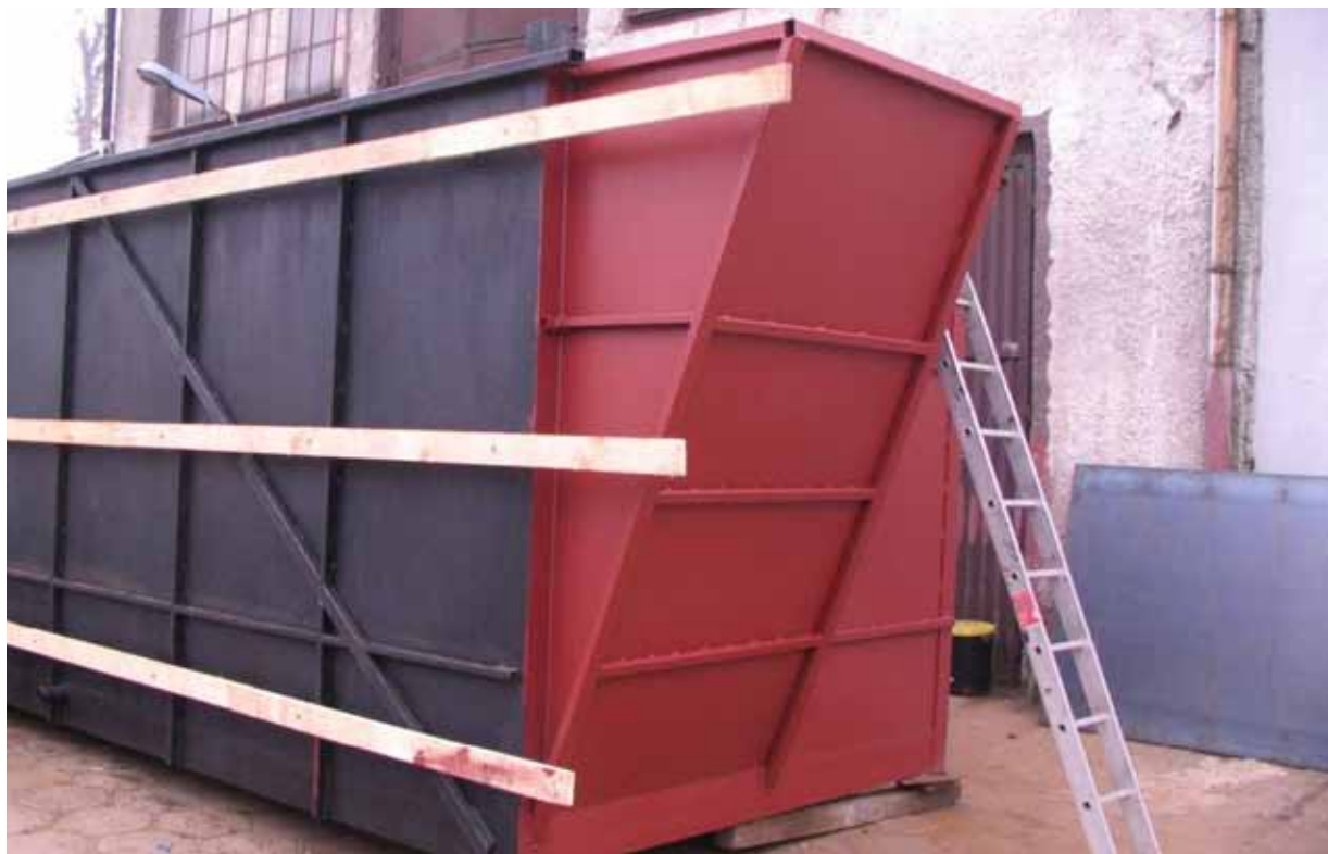
Fot. 5. KMR7 w trakcie budowy - widok na lej zasypowy
