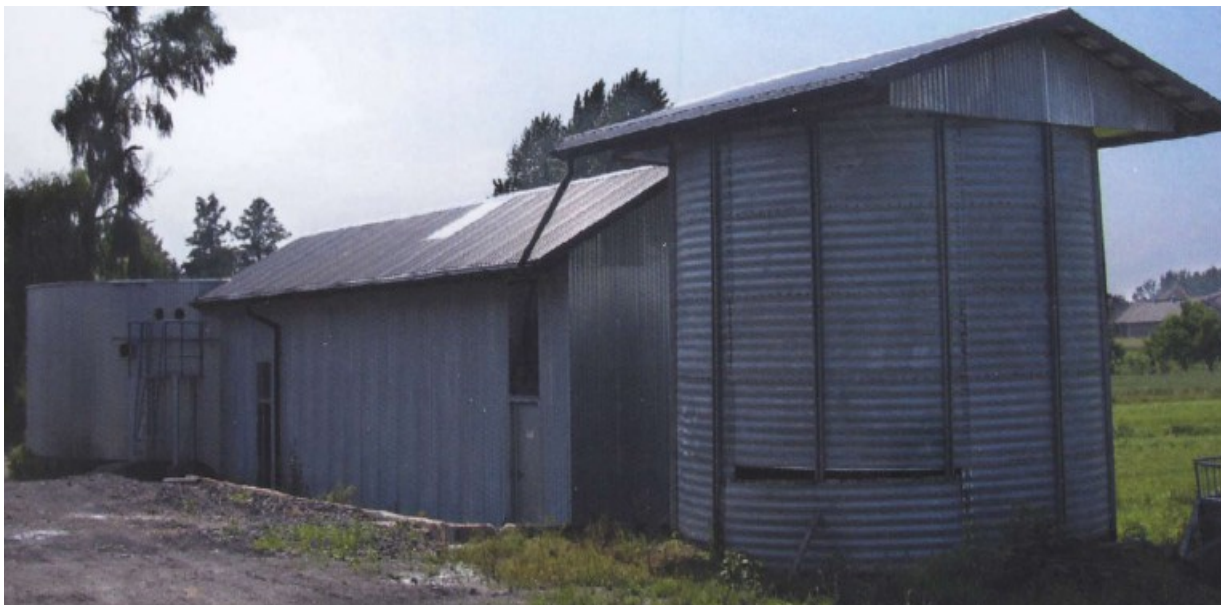
Fot. 3. Zbiornik biogazu i komory fermentacyjne biogazowni w Studzionce
