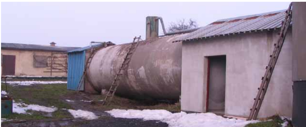
Fot. 4. Fermentator i pomieszczenie przepompowni budowanej biogazowni w Wiśle Małej Według założeń właściciela ma to być biogazownia o parametrach zbliżonych do tej ze Studzionki (porównywalne są również oba gospodarstwa rolne).
