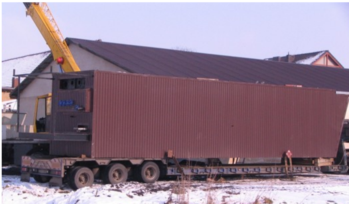
Fot. 7 Transport KMR7 na miejscu przyszłej eksploatacji
