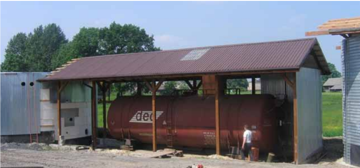
Fot. 1. Biogazownia w Studzionce w czasie budowy
